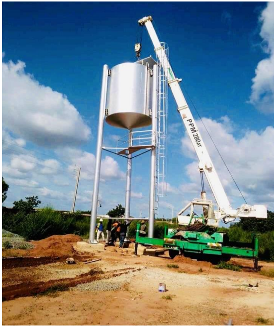
Installation d'un château d'eau au Burkina Faso
