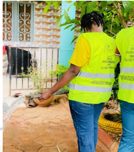
Etudes diagnostiques et entretiens d'ouvrages de stockages d'eau pour des particuliers dans la ville de Ouagadougou (Burkina Faso)
