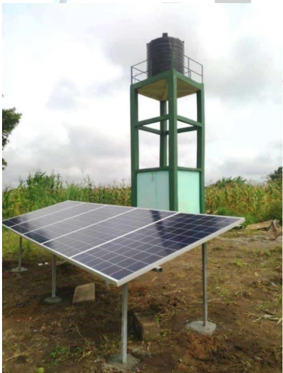
Mise en place d'un poste d'eau autonome au Togo (Région de Kara)
